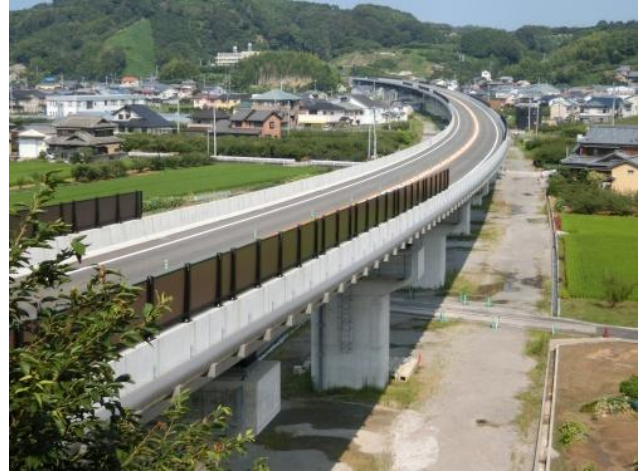
施工例 橋梁上部床版
