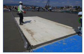
真空脱水/トワエル・金コテ仕上
