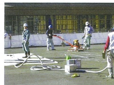
BF処理(真空脱水)
