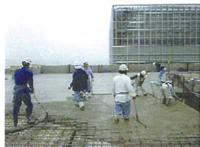
コンクリート打設・均し
