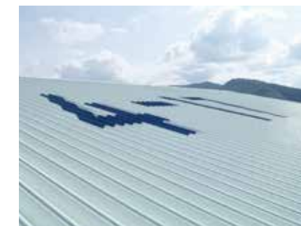
市民体育館(福井県)折板屋根(遮熱)
