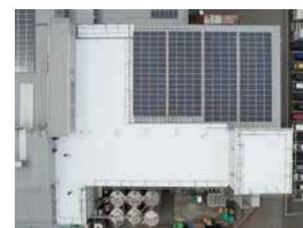
工場(福井県)折板屋根(遮熱)
