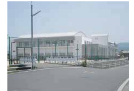
中学校(福井県)鋼板屋根(遮熱)
