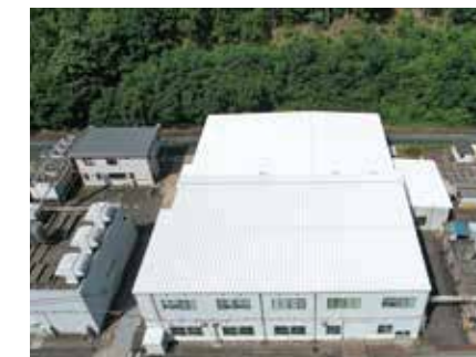
工場(福井県)折板屋根(遮熱)
